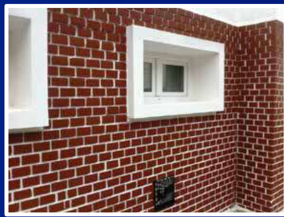
Klinker téglás épület
